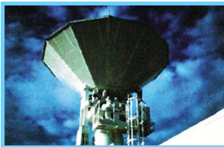
Σχήμα 8.4.5 Κεραία δορυφορικής λήψης του δικτύου ICO. Οι συχνότητες που θα χρησιμοποιούνται στο δίκτυο ICO θα είναι για τη ζεύξη των επίγειων σταθμών με τους δορυφόρους τα 5 GHz για την ανερχόμενη ζεύξη και 7 GHz για την κατερχόμενη ζεύξη (ζώνη C). Επίσης, για την επικοινωνία των συνδρομητών με τους δορυφόρους θα χρησιμοποιούνται οι περιοχές 1980-2010 MHz για την κατερχόμενη και 2170-2200 MHz για την ανερχόμενη ζεύξη.
